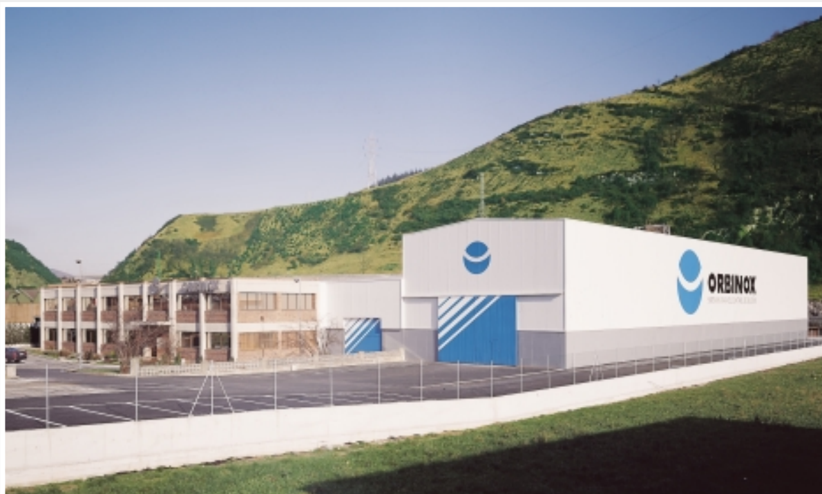
Installations d'ORBINOX à Anoeta - Tolosa, Espagne.
