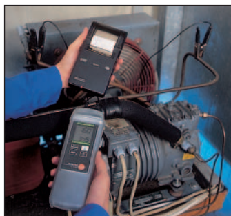
Détermination du rendement des installations frigorifiques avec impression des valeurs sur site
